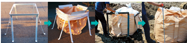
①トンサポを展開する ②大型土のう袋、羽根、③展開箇所の金具、④大型土のうの完成 接続金具を取り付け 羽根を外し、片方ずつ外す
