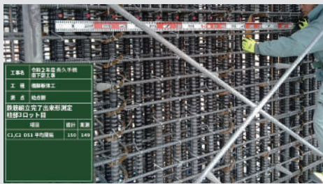
鉄筋の撮影に
