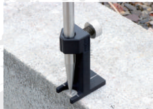
擁壁での測定に
